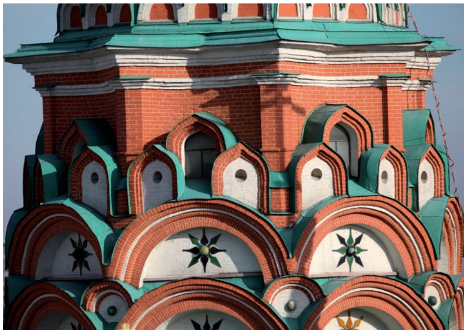
Рис. 2. Килевидные кокошники с размещенными в них керамическими сосудами на фасаде церкви Покрова Пресвятой Богородицы
