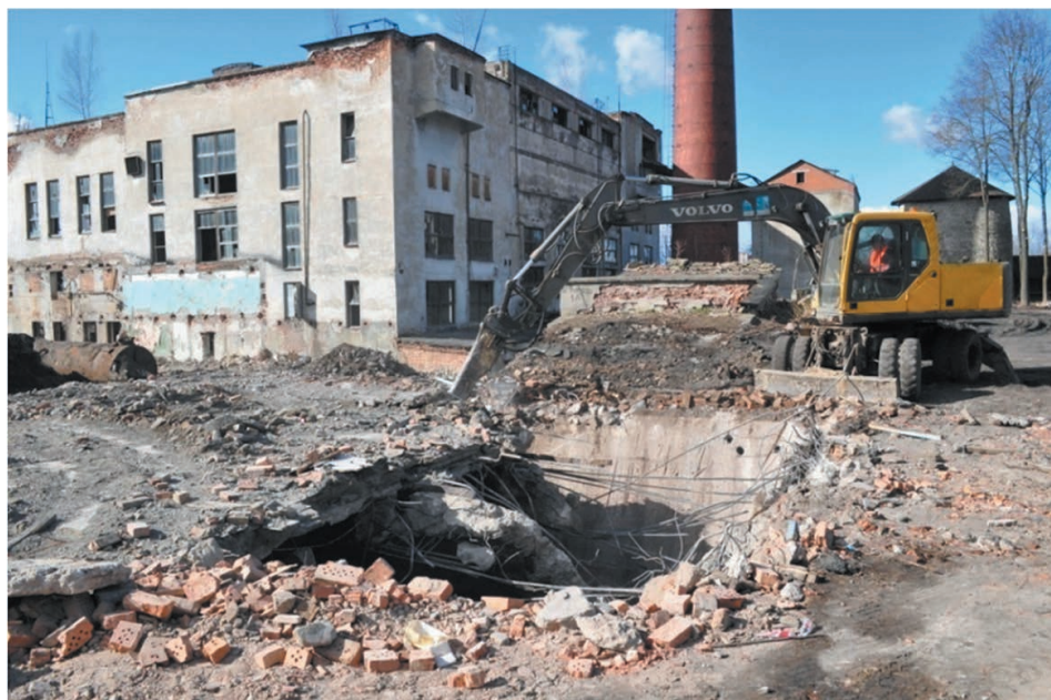
Рис. 1. Снятие балластных сооружений и демонтаж бункера XX в. перед началом работ на Мстиславских раскопах. Вид с запада
