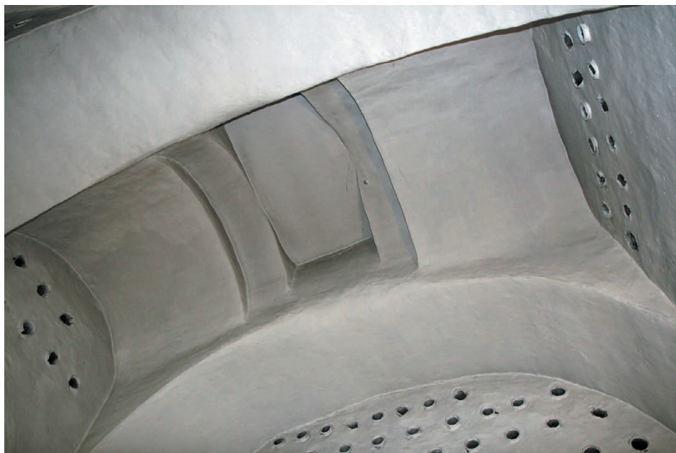
Рис. 6. Вид на распалубку и подкупольное кольцо придела
